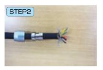
② ケーブルにコレットナット、コレットを通し、シース、各芯線の被覆を所定の寸法(各商品ページ参照)に合わせて取り除く。コネクタにアースする場合はシールドを折り返し置いておく。
